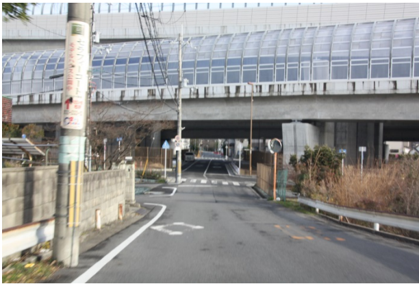
第二京阪道路の高架をくぐります。
